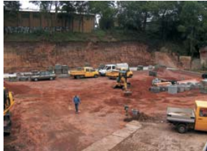
Ankunft auf derBaustelle.
